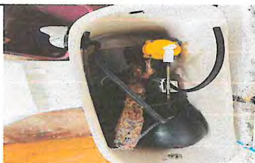
SUSTITUCION DE ACCESORIOS DE INODORO LLAVE Y TUBO DE ABASTO
