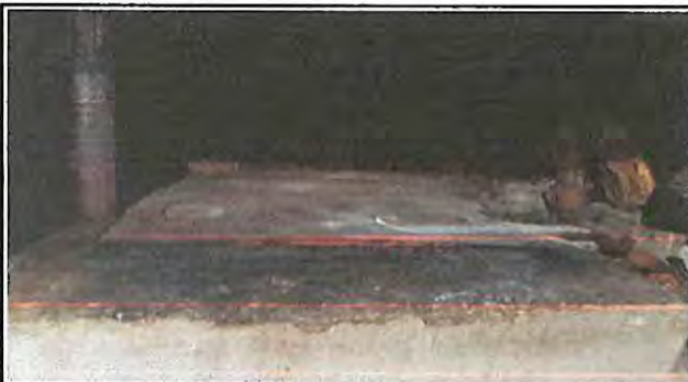
INSTALACION DE AZULEJO EN ESTUFA RURAL
