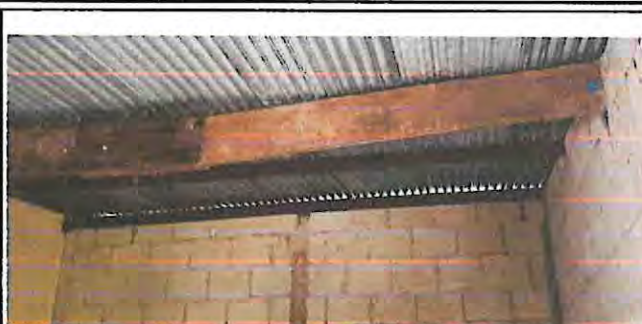
SUSTITUCION DE ESTRUCTURA DE SOPORTE DE MADERA POR METAL DE EL AULA
