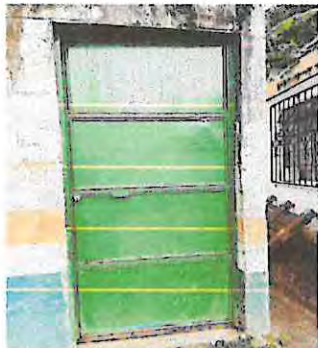
MANTENIMIENTO DE PUERTA DE METAL CAMBIO DE LAMINA,PINTURA,TUBO EN LA PARTE INFERIOR, PUERTA DE AULA
