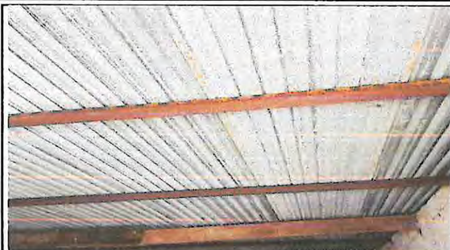
SUSTITUCION DE DE ESTRUCTURA DE SOPORTE DE MADERA POR METAL DE EL AULA
