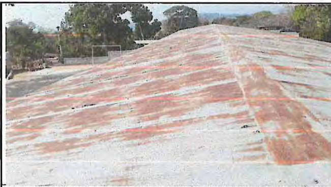
SUSTITUCION DE LAMINA ACANALADA POR TROQUELADA
