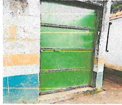
MANTENIMIENTO DE PUERTA DE METAL CAMBIO DE LAMINA,PINTURA,TUBO EN LA PARTE INFERIOR,PUERTA DE AULA
