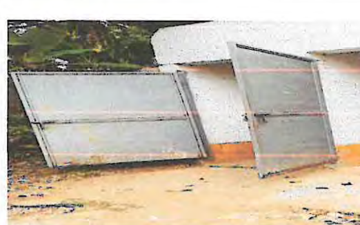
MANTENIMIENTO A PUERTAS DE SANITARIOS CAMBIO DE TUBO, LAMINA Y PINTURA
