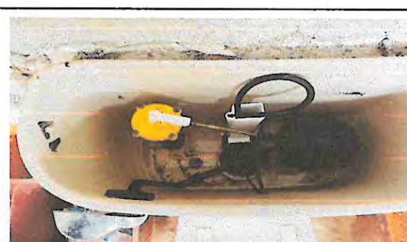
SUSTITUCION DE ACCESORIOS DE INODORO LLAVE Y TUBO DE ABASTO
