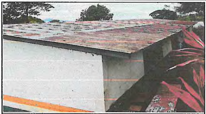
SUSTITUCION DE LAMINA ACANALADA POR TROQUELADA
