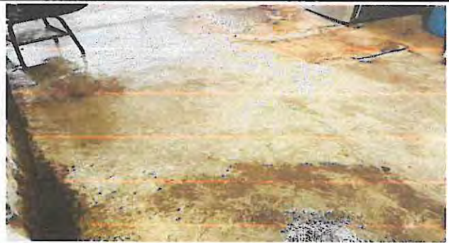
SUSTITUCION DE PISO DE CONCRETO POR CERAMICO EN COCINA
